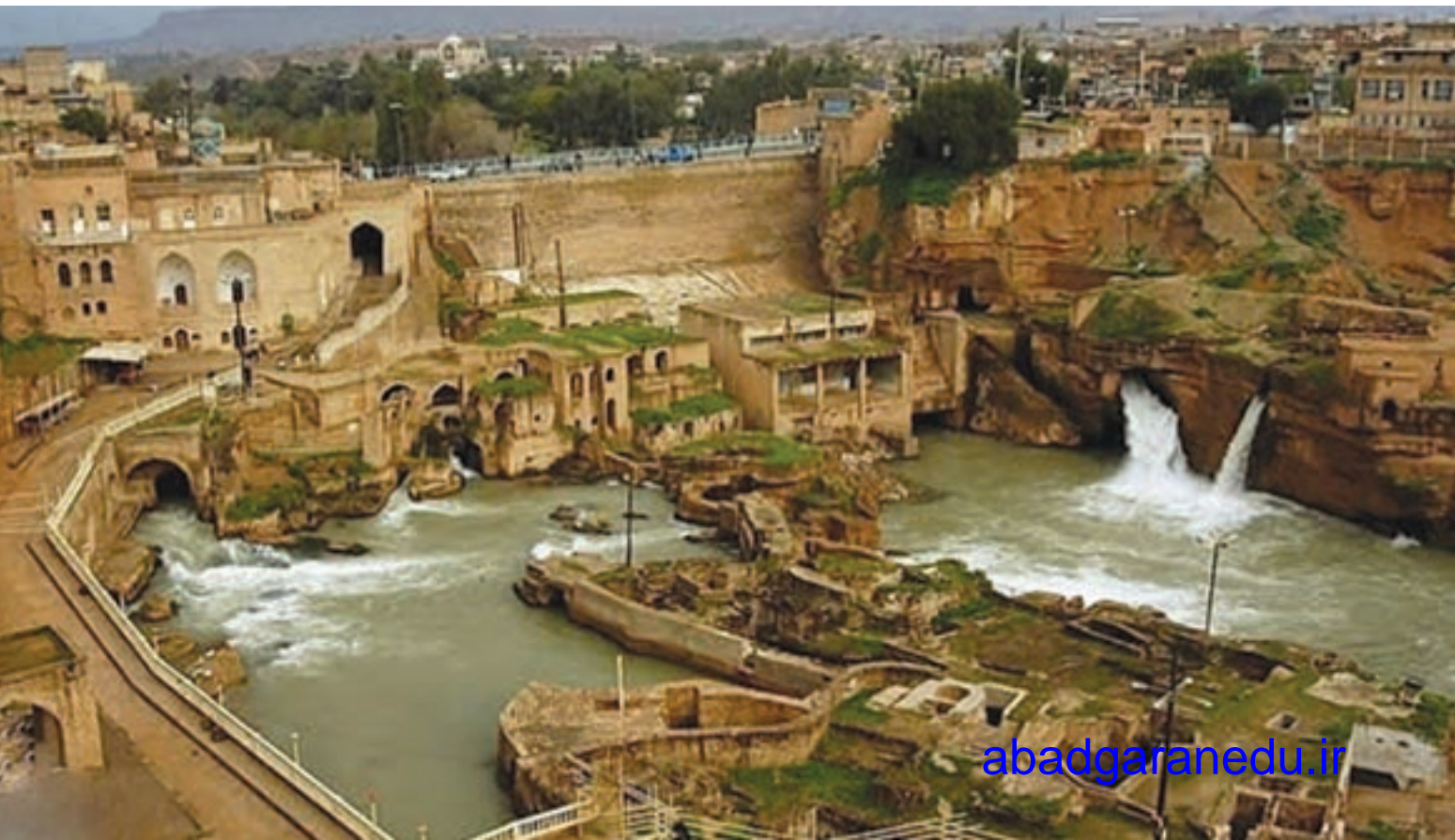
شکل ۵- سازه‌های آبی - تاریخی، شوشتر، خوزستان
