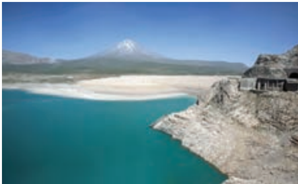
شکل ۸- سد لار در تهران، در مکان مناسبی احداث نشده است.
