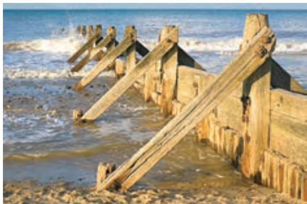
نصب حفاظ عمودی
