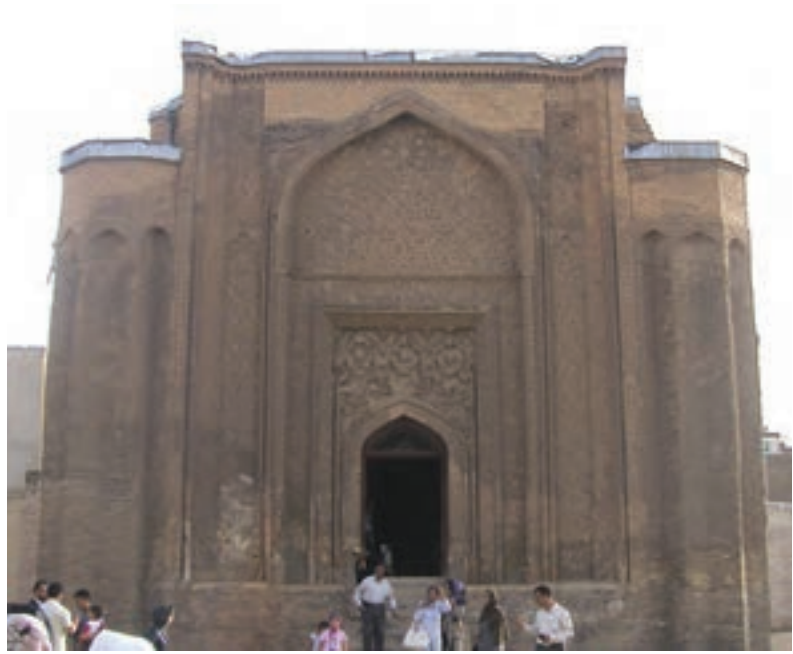
گنبد علویان از بناهای دوره سلجوقی - همدان
