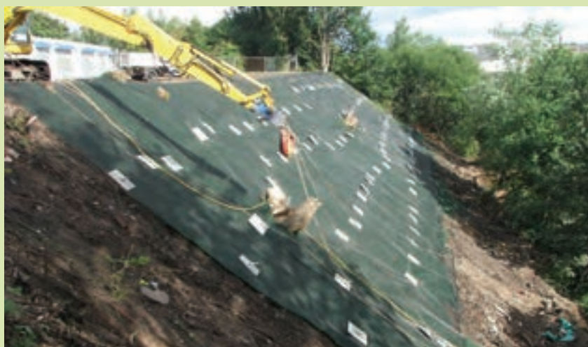
پایدارسازی شیب به روش میخ‌کوبی
