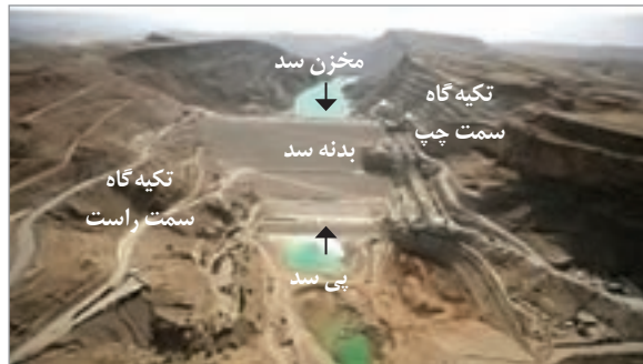
شکل ۵-۴- نمایی از بخش‌های مختلف یک سد
