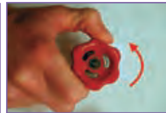
ح - باز کردن شیر فلکه اصلی
