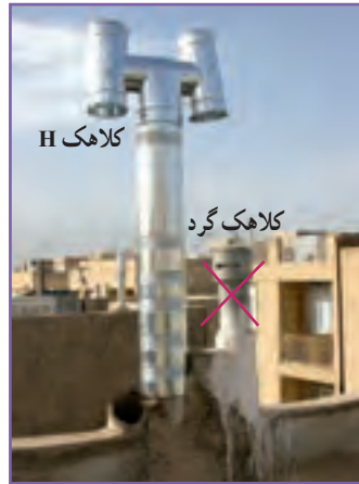
ب - فاصله بین دودکش تا کولر آبی و یا پ - برای خروجی دودکش هر دستگاه گازسوز یک کلاهک H نصب شود. دریچه های تأمین هوای ساختمان دست کم سه متر باشد.
