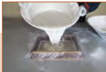
ث - ریختن ملات گچ در قالب
