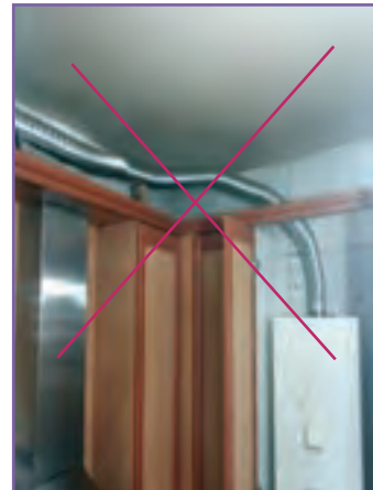
ح - هرگز از لوله های خرطومی به جای لوله رابط دودکش استفاده نکنید.
