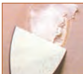
ب - لکه گیری و ترمیم ترک‌ها
