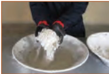
ب - اضافه کردن گچ به آب
