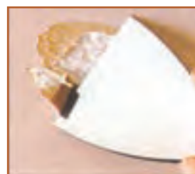
الف - باز کردن ترک‌ها
