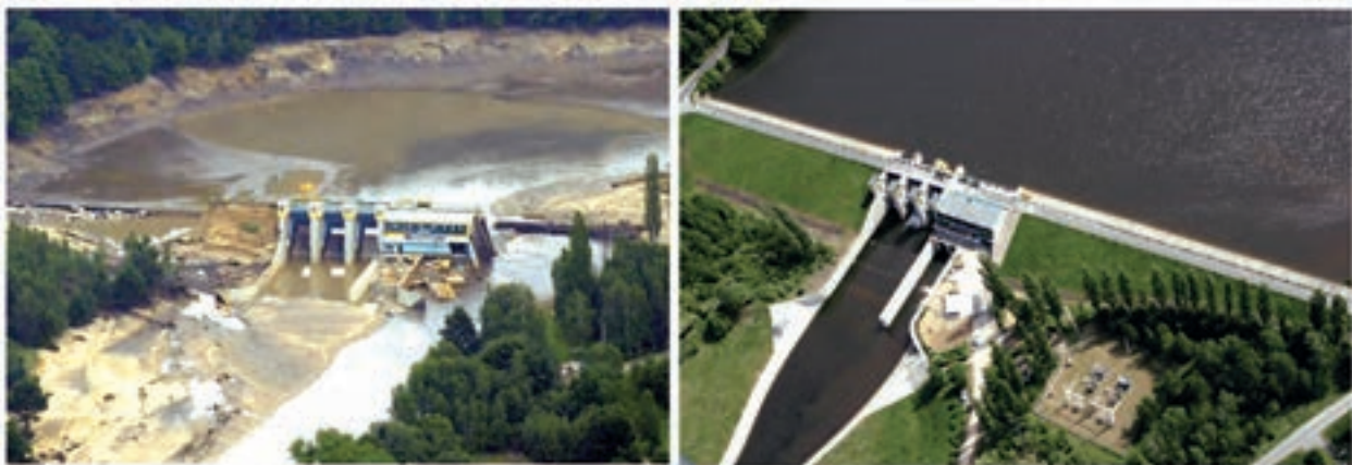
تصویر قبل و بعد از شکسته شدن سد نیداو در کشور لهستان
