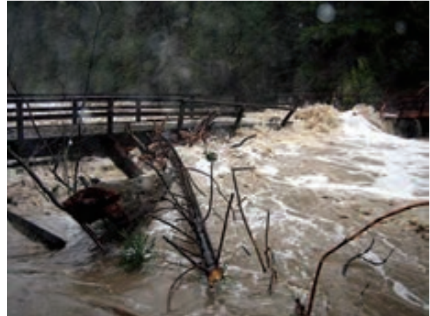
تخریب پل در اثر سیلاب منطقه تنگ کینشت، استان کرمانشاه و مسدود شدن دهانه پل با تنه و شاخ و برگ درختان موجب سرریز شدن سیل و تخریب پل می شود.
